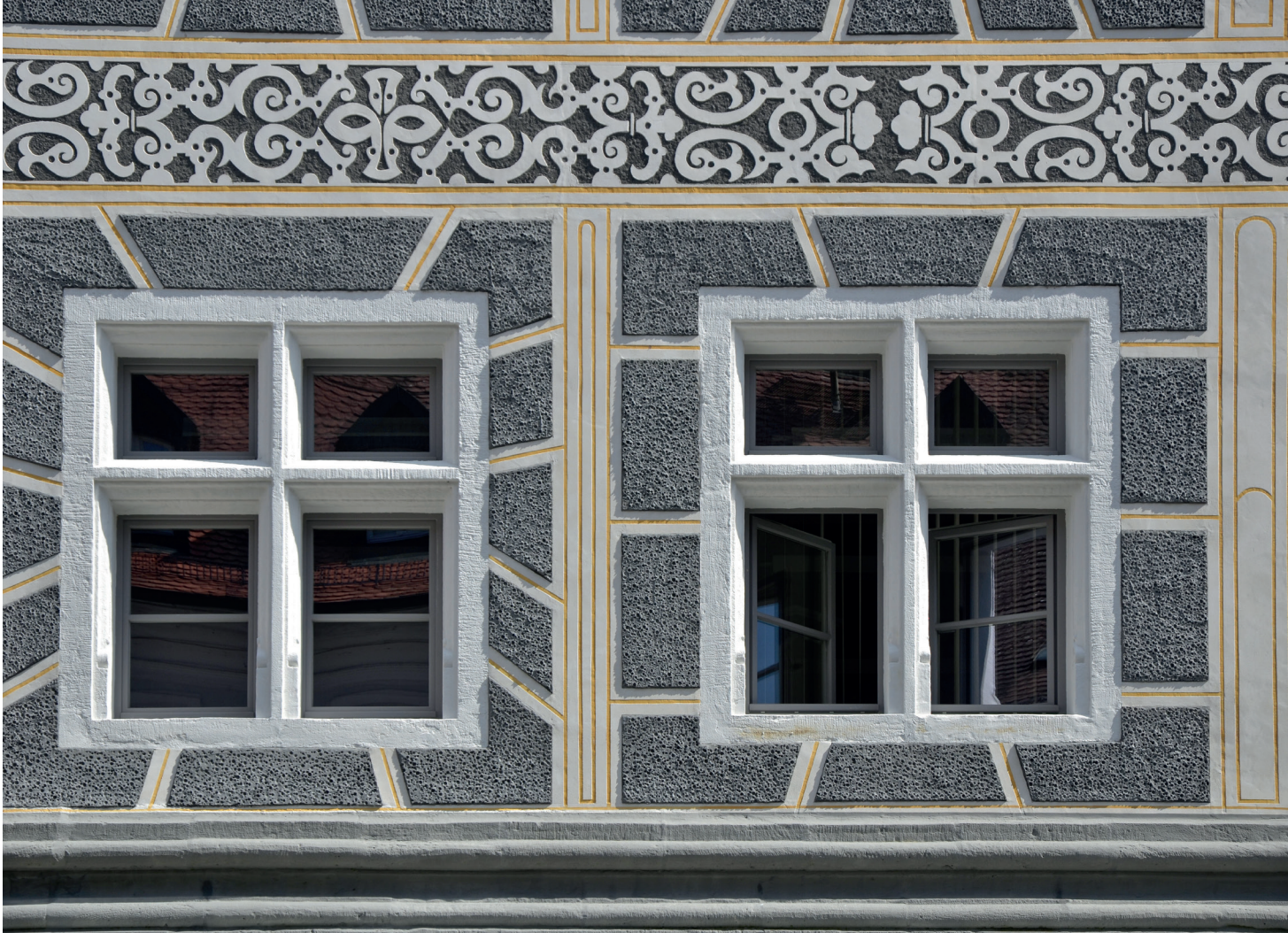
Sanierung Verwaltungsgerichtshof Ansbach, © Staatliches Bauamt Ansbach
